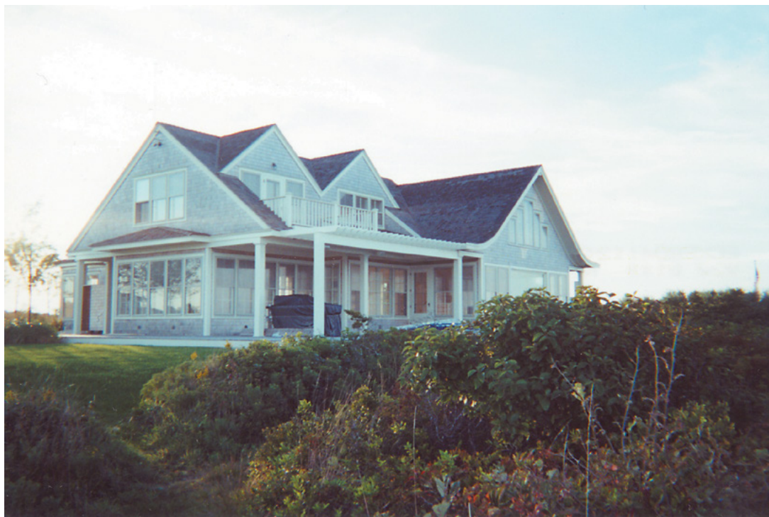
Figura 1 Vista exterior da casa (home theater no subsolo).
