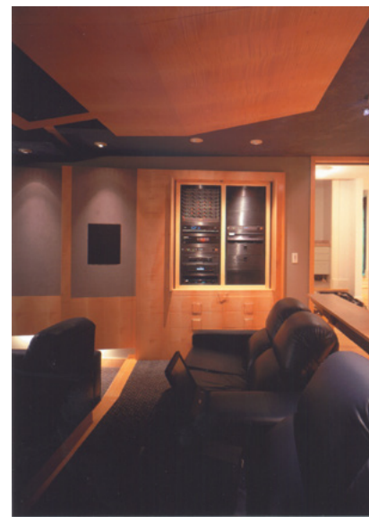
Figura 14 Interior do home - vista do armário de equipamentos
