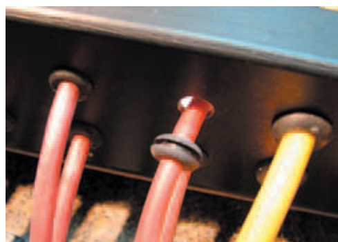
Figura T-07: Podemos observar a peculiar forma de este tipo de arruela passa-cabos antes de ser fixada na chapa.
