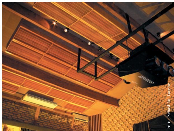
Detalhes do tratamento acústico do teto
