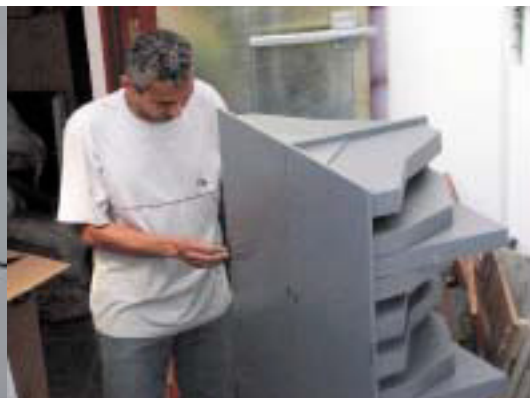
Figura 5: montagem de uma coluna de difusores de frequências médias.
