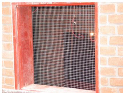
(20-02-2004) Da mesma forma que nas portas, as duas janelas de iluminação da discoteca e antecâmara mantêm a malha afixada a um marco metálico de fixação. Sobre ele poderá ser colocado um elemento adicional de isolamento acústico (ver texto).
