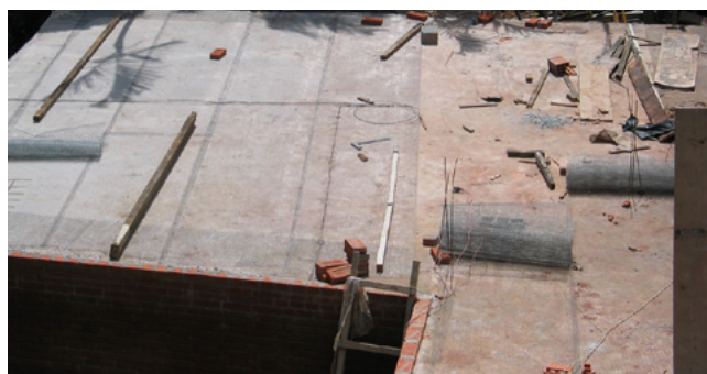
(09-02-2004) ...e é estendida por cima. Observe as faixas (o rolo de malha vem com um metro de largura). Elas são unidas com fio de cobre nu e soldadas, procedimento realizado ...
