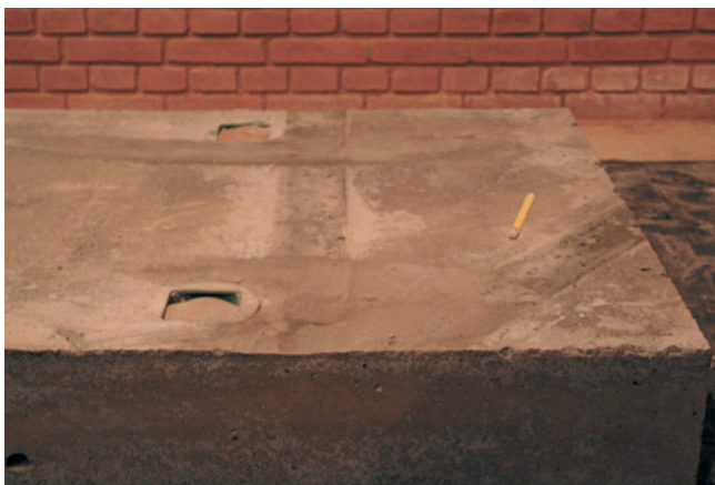
Fig 18: No segundo dia após a colocação do concreto no molde são retiradas as madeiras do molde. Vemos aqui o lado direito da laje de 20 cm de altura, onde identificamos a parte superior dos cilindros da GERB, dentro dos quais serão colocadas as molas e (olhando com atenção); à esquerda, encontra-se o orifício que corresponde a um cano de aço galvanizado de uma polegada que será embutido no concreto. Servirá para o caso de haver necessidade de movimentar a laje antes de ser suspensa.
