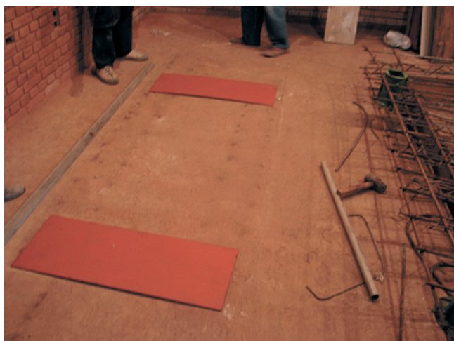
Fig 10: Após marcar no contra-piso, a localização e medidas exatas da laje, são colocadas as bases de chapa de ferro sobre as quais as molas serão apoiadas. São elas que suportarão os 1600 kg da laje...
