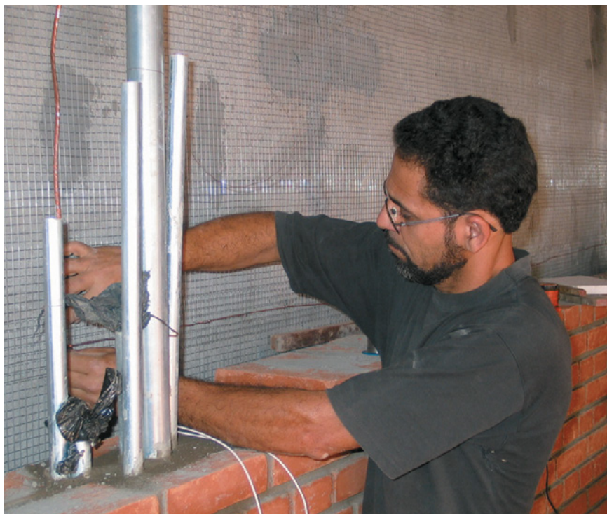
(10-12-2003) Vemos João acertando a conexão da malha por trás dos canos que levam os circuitos elétricos à frente da sala, por dentro da parede interna. A malha está fixada na parede externa, que vemos em cor mais clara.
