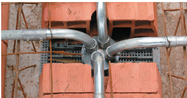
(23-01-2004) Antes de concretar a laje superior, todos os conduítes são colocados nos seus lugares...
