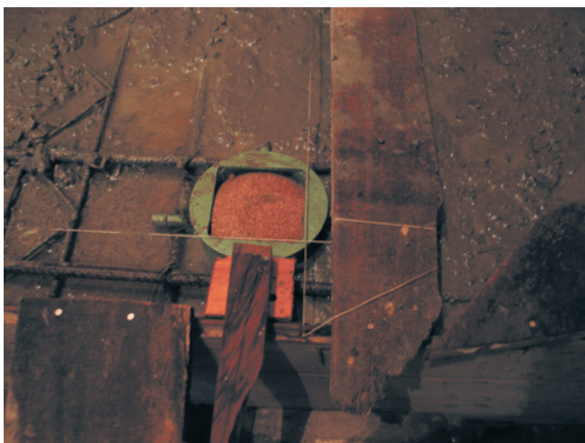
Fig 16: ...após o que o cilindro é fixado na sua posição, mantendo os fios de referência para evitar qualquer movimento durante o preenchimento da laje.
