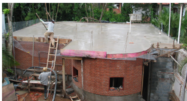
(24-01-2004) ...que, finalmente, é coberta por concreto. Observem a malha em todo o contorno que sobe dentro do espaço da parede dupla. Aqui vemos a malha rebatida para o exterior.
