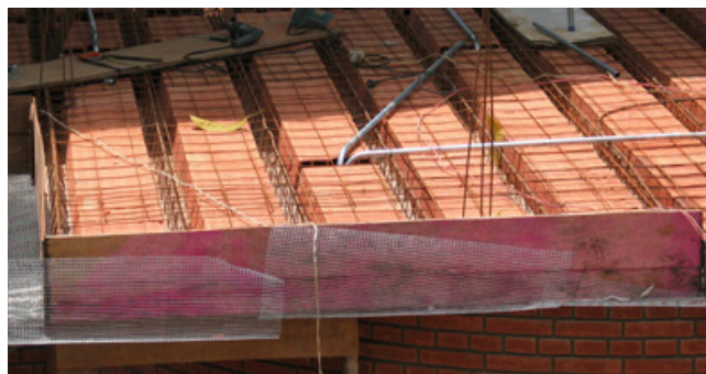
(23-01-2004) ...antes de concretar a laje. Vemos a malha que, vindo da face interna da parede externa, é refletida sobre a borda externa da laje para cobrir a parte superior da mesma posteriormente ao concretado.
