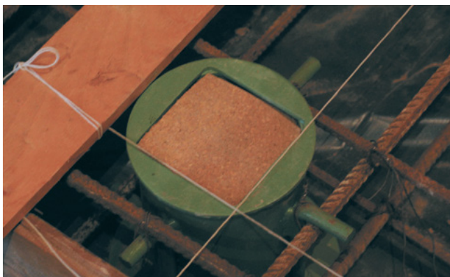
Fig 14: Verifica-se o perfeito posicionamento e alinhamento dos cilindros...
