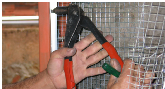
(23-02-2004). A malha está sendo rebitada no marco metálico da porta que, por sua vez, terá uma cobertura metálica. Dessa forma, existe continuidade da gaiola mesmo sobre as portas.
