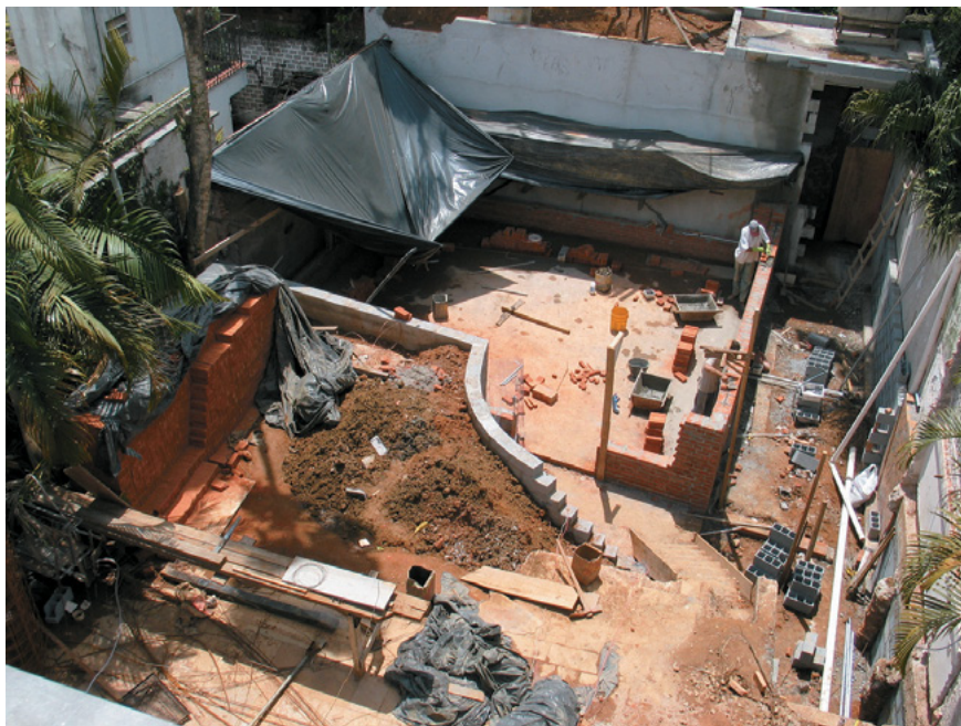
Uma imagem (5/12/03) que dá uma idéia geral da estrutura, ainda com muito a fazer, tomada do alto da casa. As lonas de plástico estão colocadas para evitar que entre água entre as paredes e que esta possa impregnar as mantas de fibra isolante. Ao fundo vemos o "caixão" de terra para jardim e o teto da extensão do laboratório, cuja parte principal vemos à direita. A parede em tijolo aparente é a parede interna, e a de cor clara, a parede externa.
