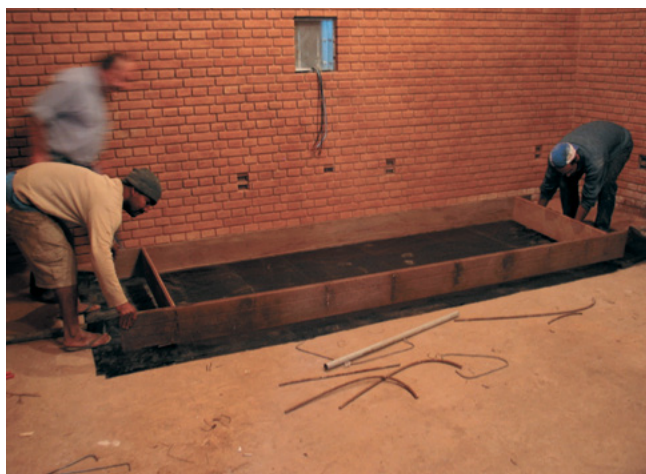
Fig 12: A caixa é, então, colocada sobre o plástico...
