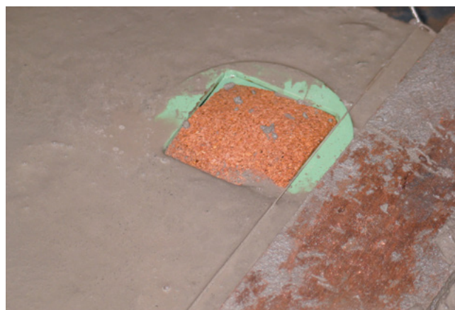
Fig 17: Finalmente o conjunto é preenchido com o concreto até nivelar a altura dos cilindros, em cujo topo coloca-se cortiça para evitar que o cimento entre em seu interior e dificulte a posterior colocação das molas e seus suportes.
