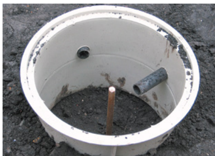
Fig 01-a: Uma das varetas de aterramento com sua caixa de inspeção com conduítes de ligação com as outras...
