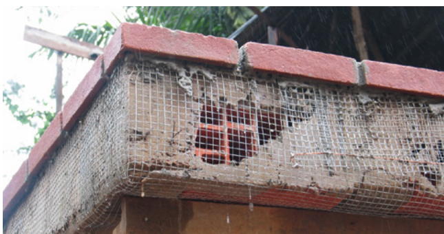
(06-02-200) Uma vez rebatida por fora do contorno da laje recém cimentada, a malha passa sob os tijolos que formam a borda do terraço superior...
