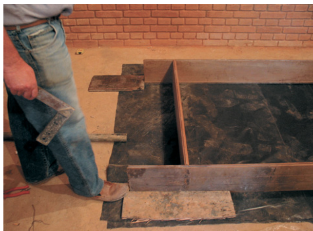
Fig 13: ...e cuidadosamente fixada no lugar pré-estabelecido. Após ter sido verificado o paralelismo com a parede do fundo e a simetria com as paredes laterais.
