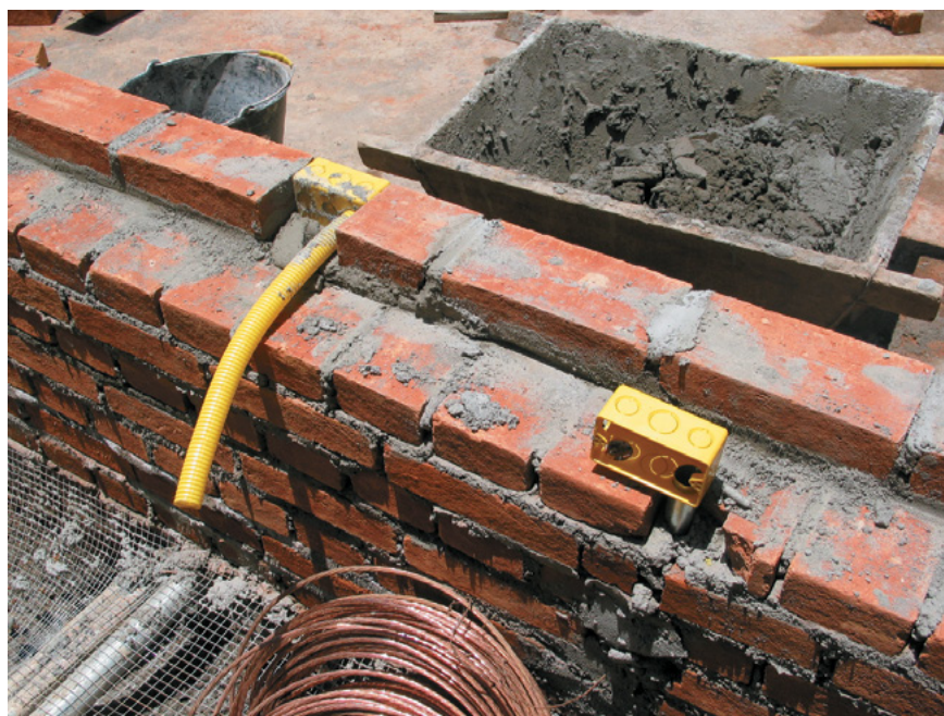
Adivinhem (02-12-2003)! Giner descobriu que colocar duas caixinhas de terminais elétricos frente a frente criava um curto-circuito sonoro entre a sala e o laboratório. Lá vai João para concertar e recolocar as caixas, afastando-as uma da outra...Vemos a malha metálica que irá soldada nela e o rolo de cabo de cobre para uni-la e manter uma estreita ligação elétrica de baixa impedância que garantam um equipotencial em toda a sua extensão.
