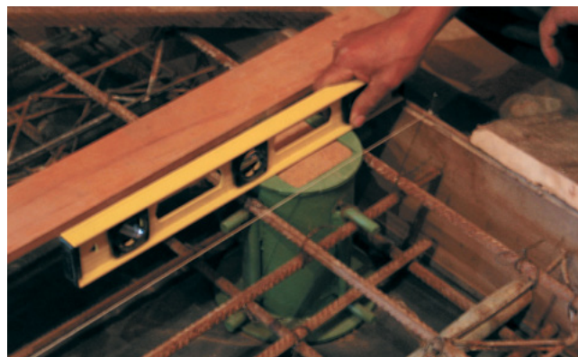
Fig 15: ...o seu paralelismo com a futura superfície da laje (ou seja, também, o seu perfeito alinhamento vertical para permitir que a mola trabalhe alinhada com o cilindro e apóie no chão em forma plana)...
