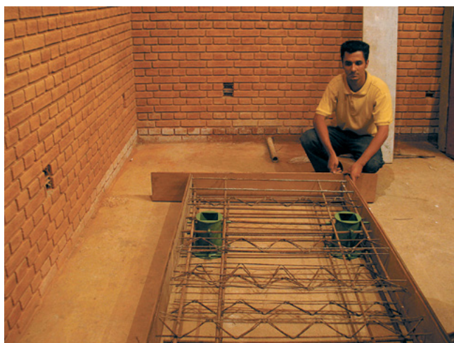
Fig 08: Depois de construída a estrutura metálica da laje (vemos aqui a Serginho verificando o conjunto)...
