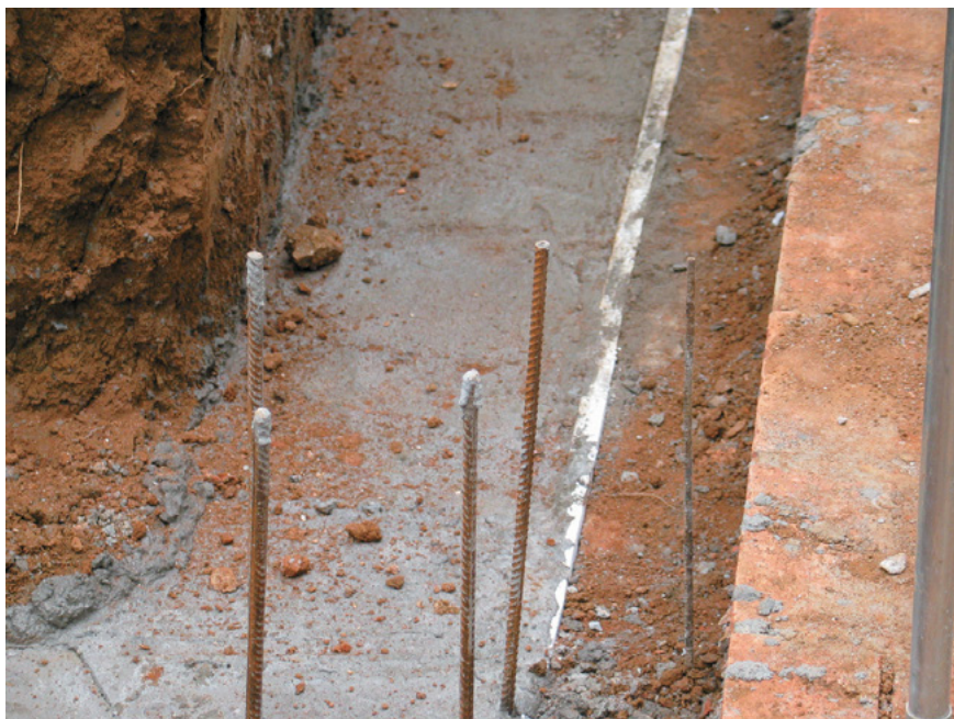
Esta foto (22-11-2003) mostra-nos o início da parede interna, já sobre a sua viga de baldrame, e, separada, a viga de baldrame da parede externa, no ponto em que se abre em semicírculo. Em todo o perímetro onde as paredes correm paralelas não existe outro ponto de contato entre elas, a não ser a terra existente entre as vigas de baldrame.
