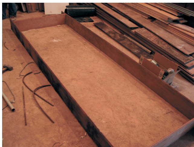
Fig 09: monta-se, em madeira, a caixa que conterá a estrutura e o concreto.
