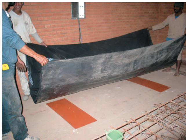
Fig 11: ...e sobre elas o plástico que evitará que a laje fique aderida ao contra-piso.
