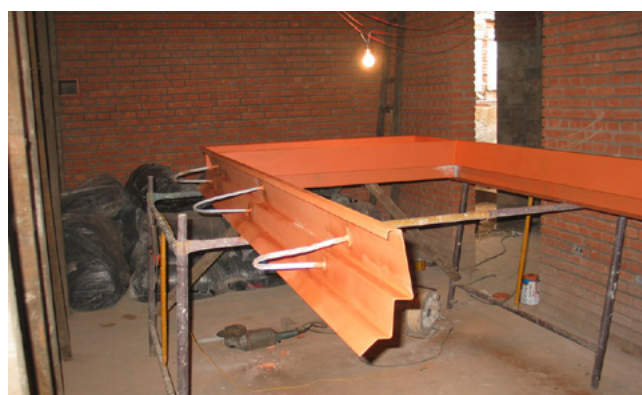
(20-02-2004) A porta externa (e também a interna) requerem um batente de forma e solidez especial, devido ao peso e aos requerimentos de solidez. Este batente está sendo construído na própria obra...
